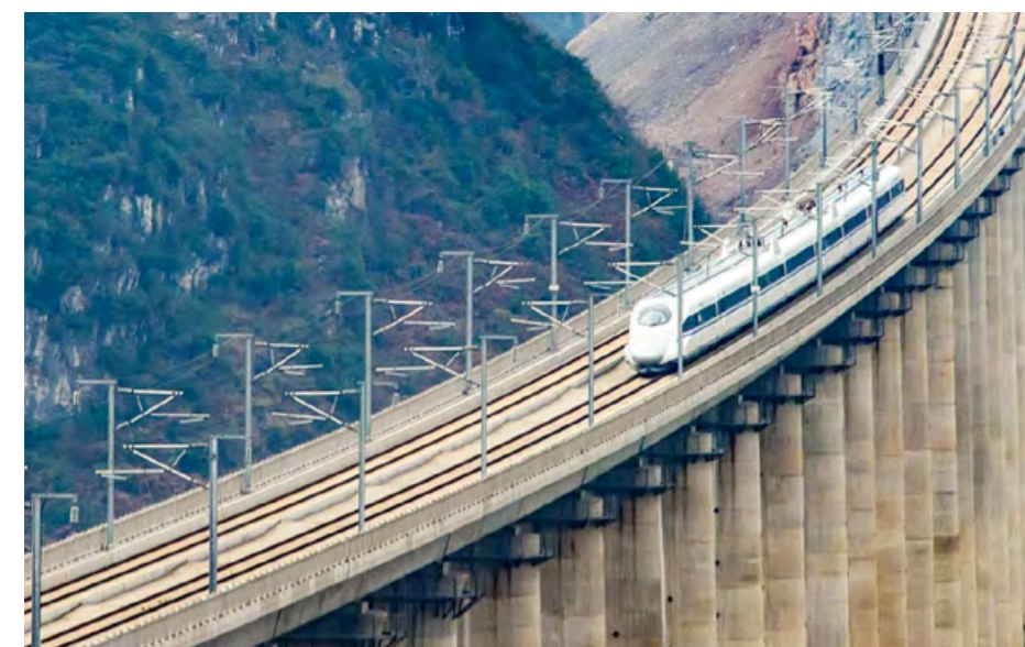
▲ 高铁施工现场
