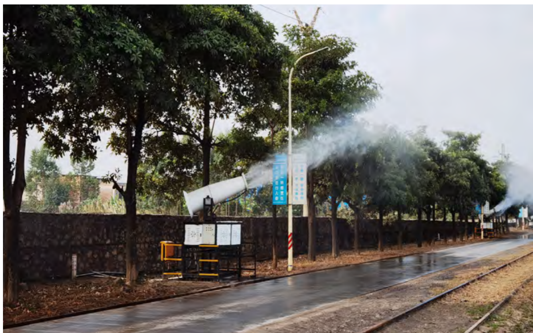
▲ 红水河水泥雾炮喷淋现场
