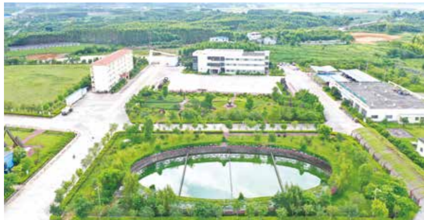
▲ 华润水泥（武宣）有限公司厂区
