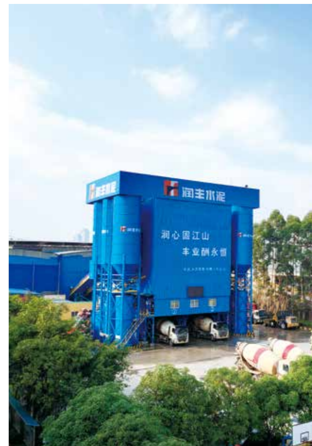
▲ 华润混凝土（广西）有限公司搅拌站
