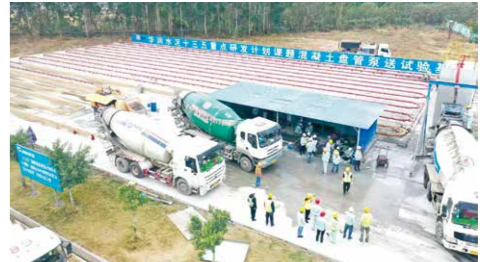
▲ 2019年12月盘管试验现场
