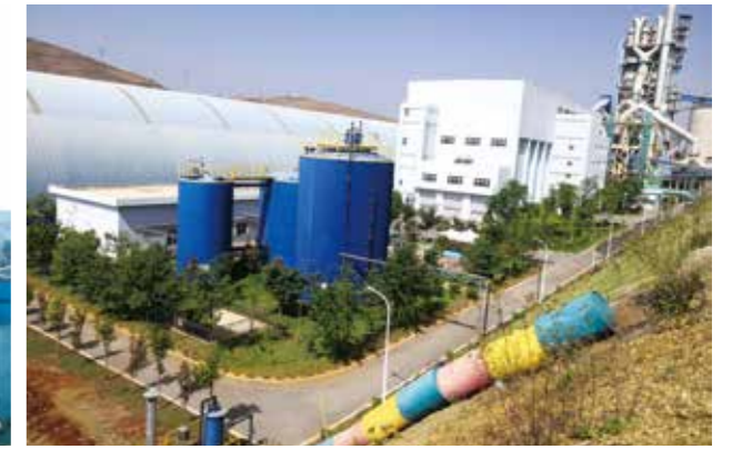
云南弥渡城乡生活垃圾协同处置项目建成投入试运营
